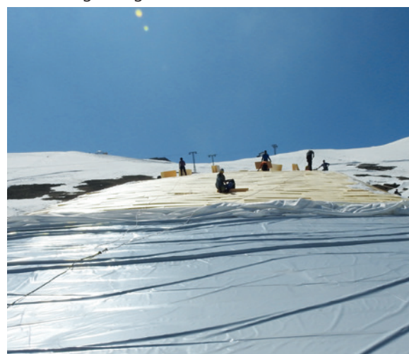
Abdeckung 1. Lage mit PE-Folie
