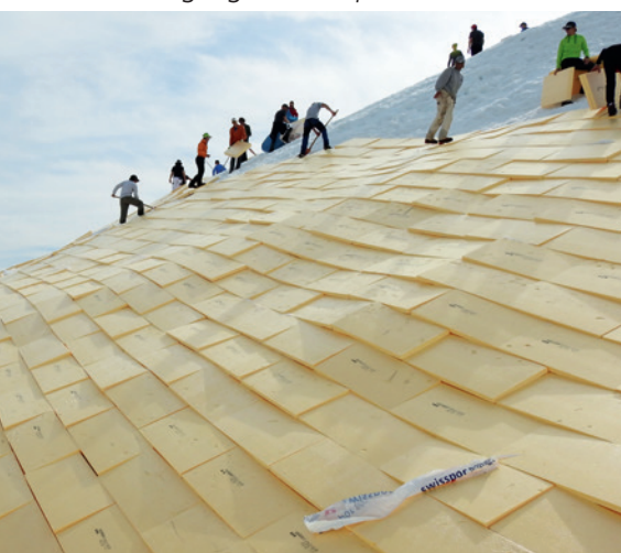
Verlegung der swissporXPS-Platten
