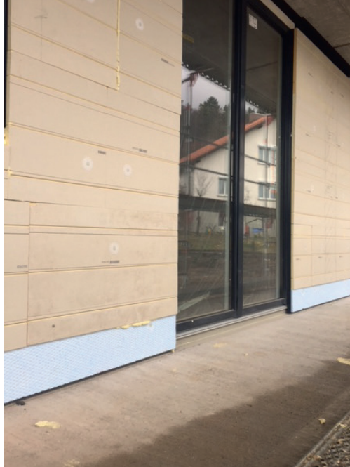
Verarbeitetes swissporPUR (PIR) bereit zur „Aufnahme“ der Holzschalung und Fassadenbekleidung
