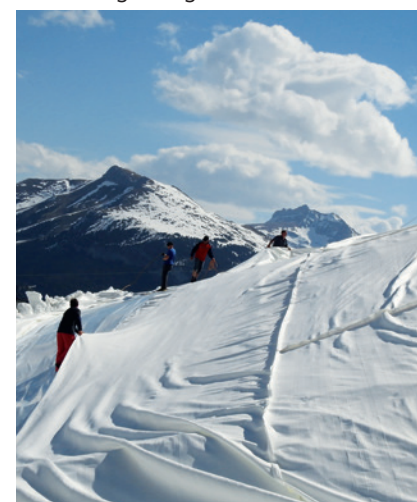
Abdeckung 2. Lage mit Gletscher-Vlies
