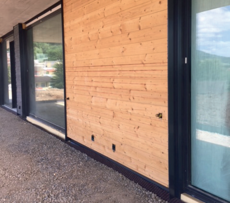
Montierte Holzschalung
