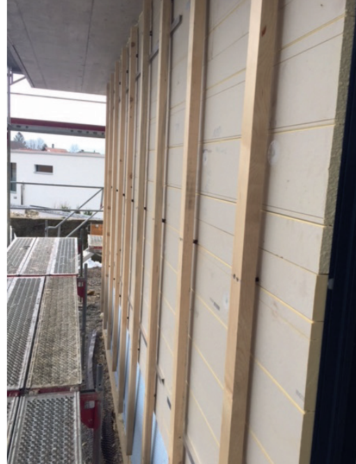
Verarbeitetes swissporPUR (PIR) bereit zur „Aufnahme“ der Holzschalung und Fassadenbekleidung
